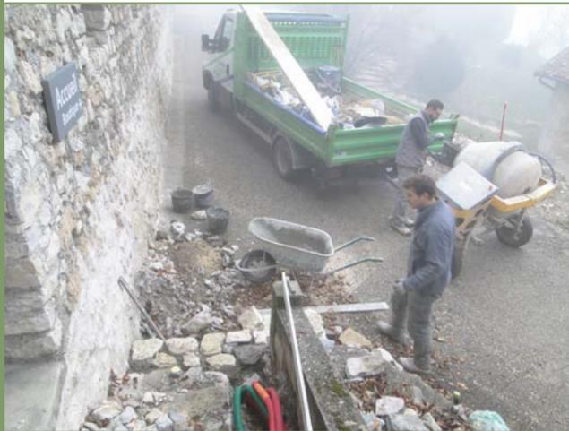
Finitions des enduits et reprise de l'escalier sous l'arrivée électrique par les maçons
