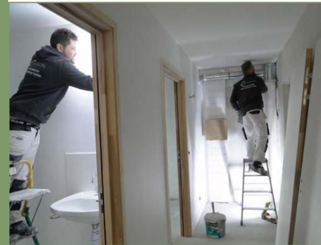
Fermeture des plafonds du rez de chaussée par les plaquistes
